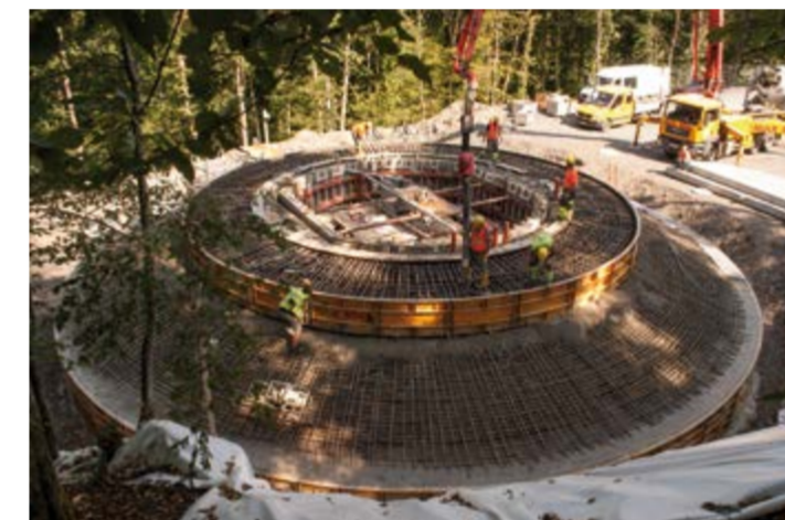
Das Betonieren des Windrad-Fundaments
