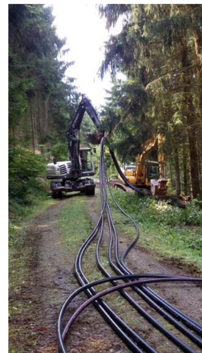
Die Kabelverlegung erfolgt meist unterirdisch, entlang bestehender Wege.
