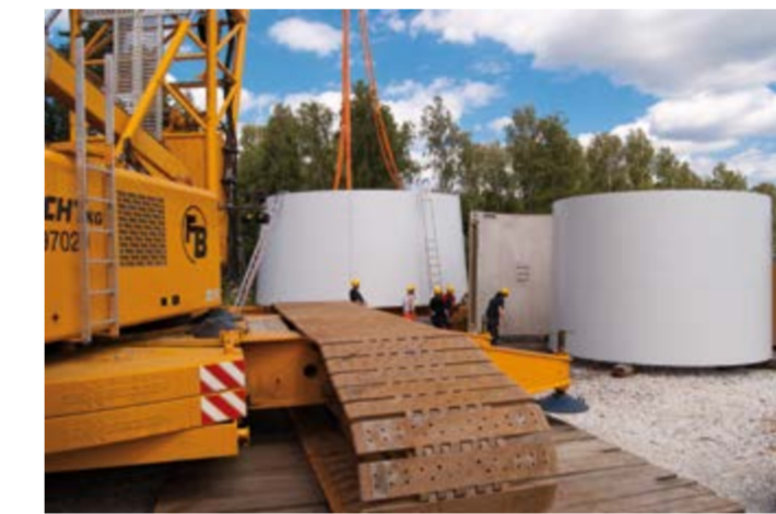
Zunächst werden die Schalen des Turms am Boden zusammengefügt...
