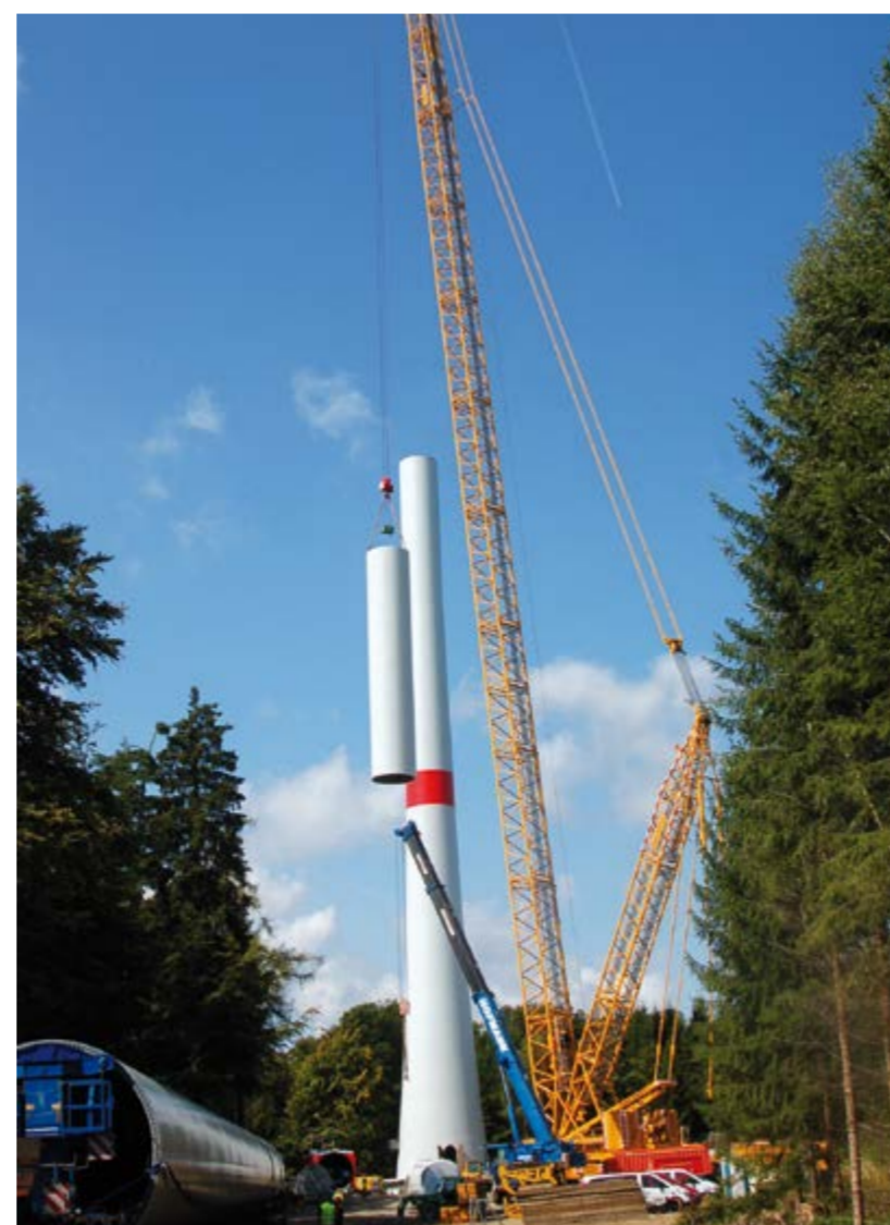
Die Montage der Stahlurmsegmente
