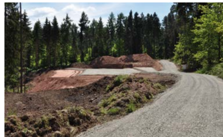
Zufahrtswege und Kranstellplatz für das Windrad
