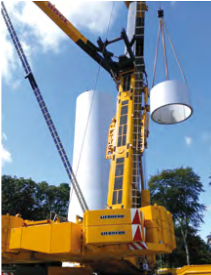
Aufbau des Betonturms
