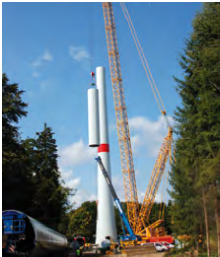
Errichtung der Stahlsegmente
