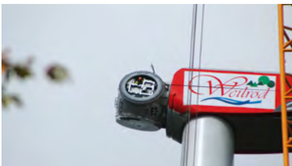
In der Nabe erwarten Monteure die Rotorblätter,...
