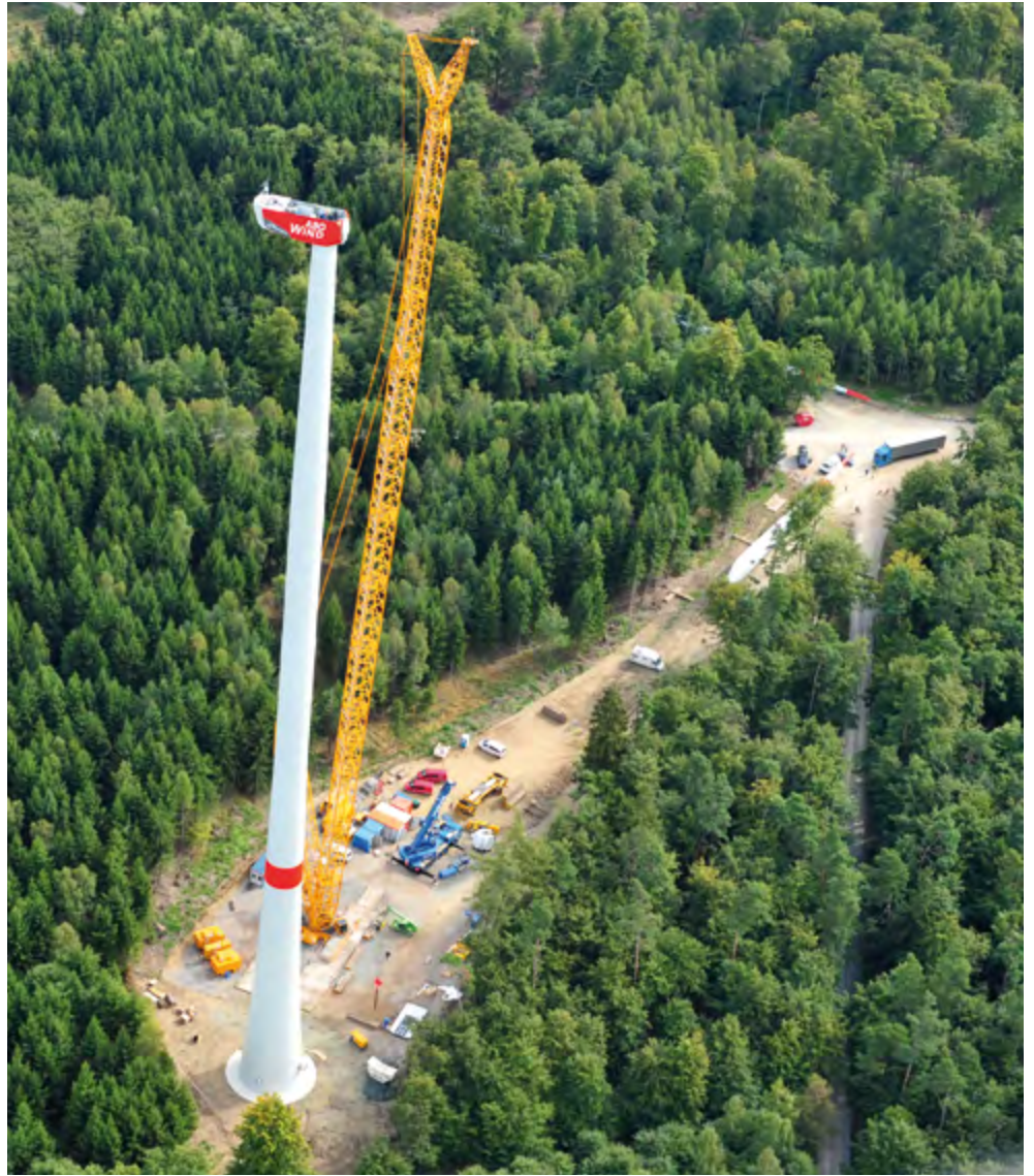
Das Maschinenhaus ist installiert
