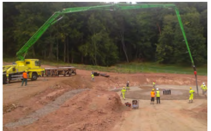
Auftragen der Sauberkeitsschicht zur Vorbereitung des Fundamentbaus.
