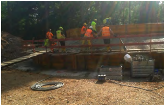
Eines der Fundamente des Windparks Jungenwald mit innerer und äußerer Schalung.
