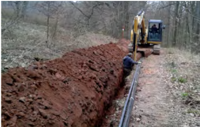
Bau der Kabeltrassen des Windparks Jungenwald.
