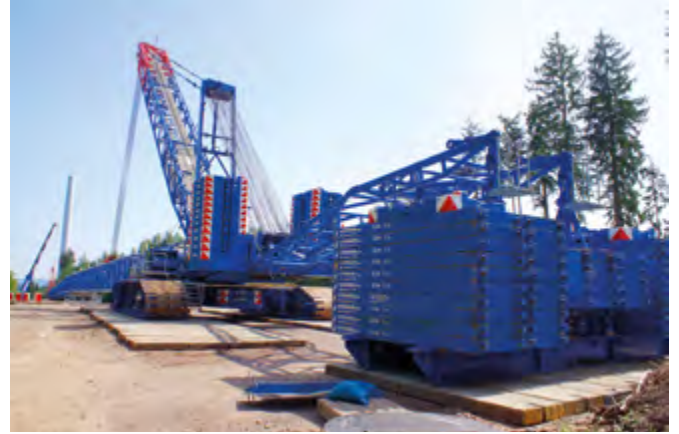
Der Kran für den Bau des Turms wird auf der Baustelle errichtet.
