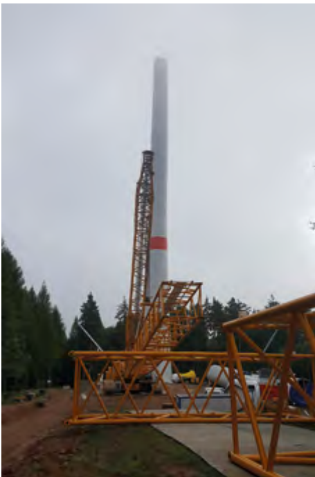
Die unteren 97,8 Meter des Turms bestehen aus Betonelementen. Die Schalen werden zunächst am Boden zusammengefügt und dann aufeinandergesetzt.
