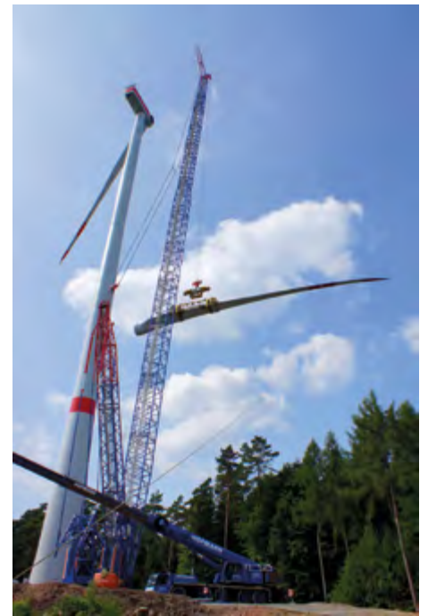
An Waldstandorten werden die Rotorblätter einzeln montiert, da so weniger Fläche benötigt wird als bei einer Sternmontage am Boden.
