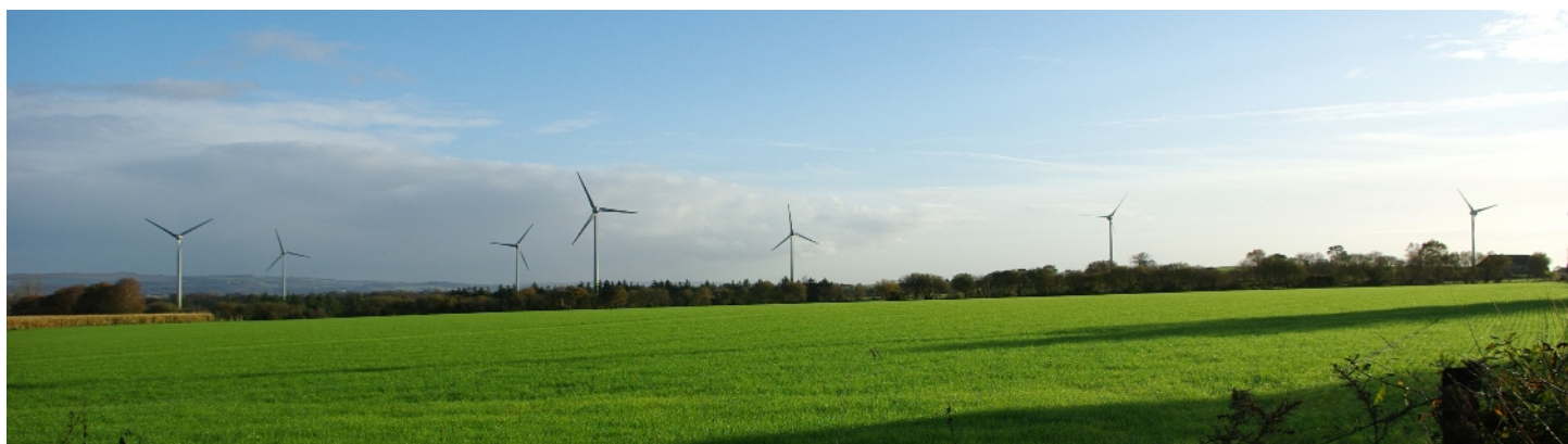
Parc éolien de Roudoualec (56)
