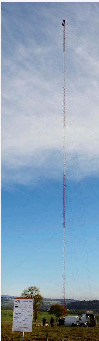
Photo d'un mât de mesure
