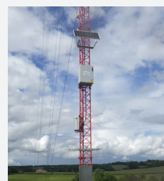
Coffret data logger Enregistre et transmet les données mesurées
