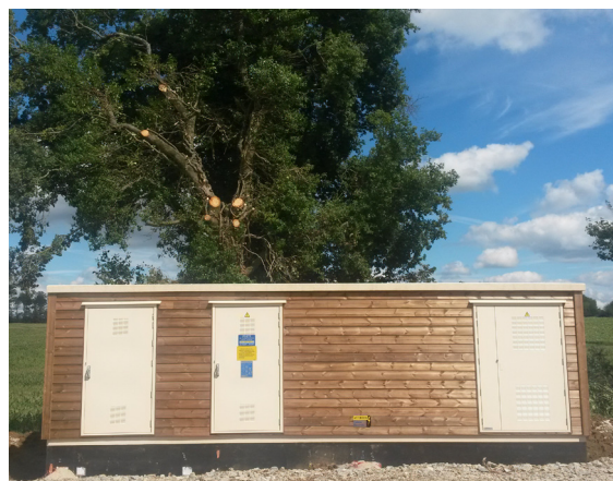
Bardage en bois d'un poste de livraison
