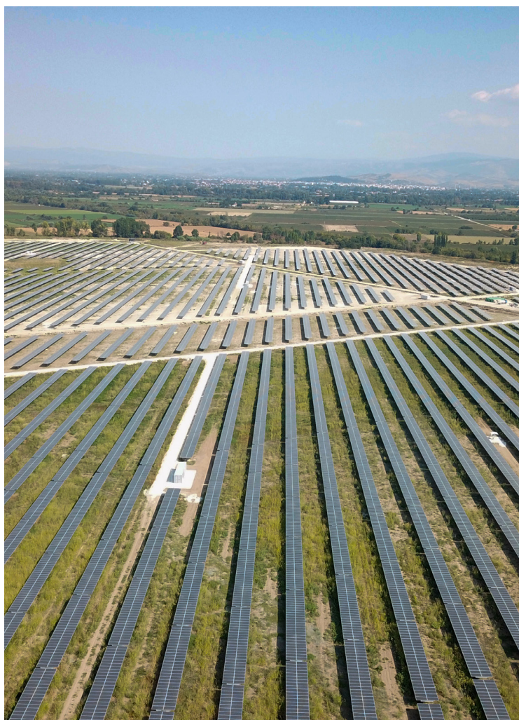
©ABO Wind - parc photovoltaïque de Megala
