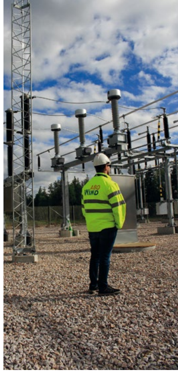
Verkkoliitäntä ja sähköasema
