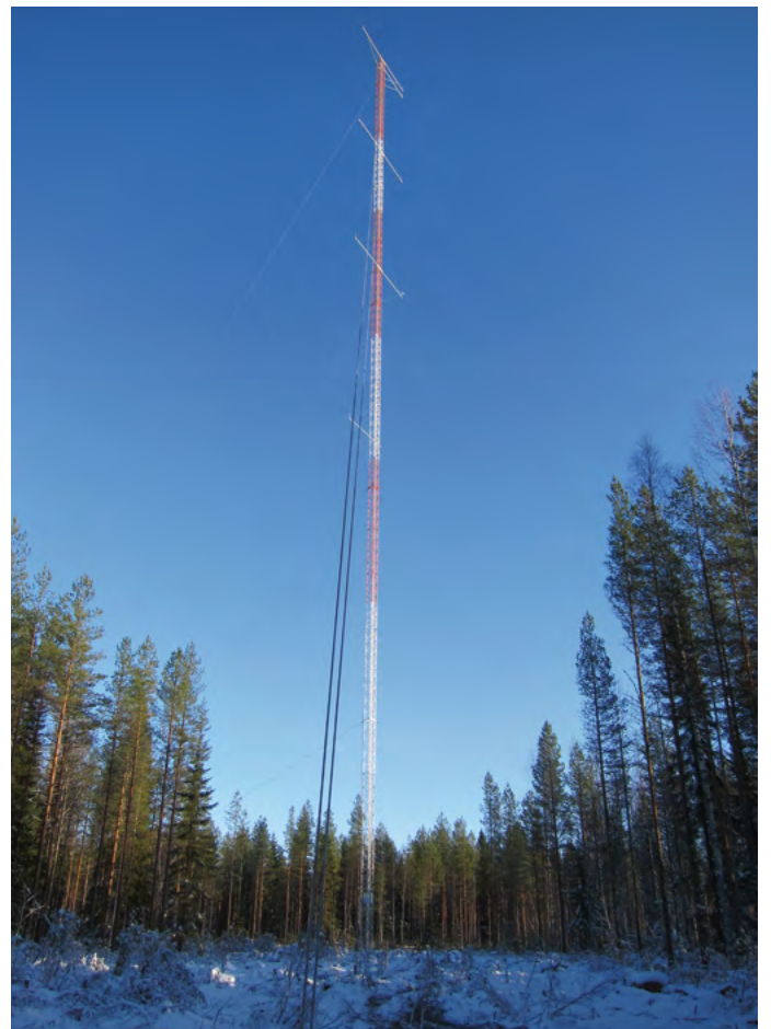
Hyvät tuuliolosuhteet varmistetaan tuulimittausten avulla. Kuvassa tuulimittausmasto Pyhäjoella marraskuussa 2013.
