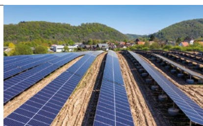
Bodenwerder, Alemania, 750 kWp, reutilización de un vertedero (2019)
