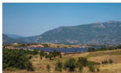
Kossos, Grecia, 7 MWp, instalación en campo libre sobre terreno irregular (2019)
