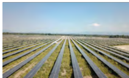
Megala Kalyvia, Grecia, 38 MWp, incluida la subestación de 34,5 MVA EPC (2020)
